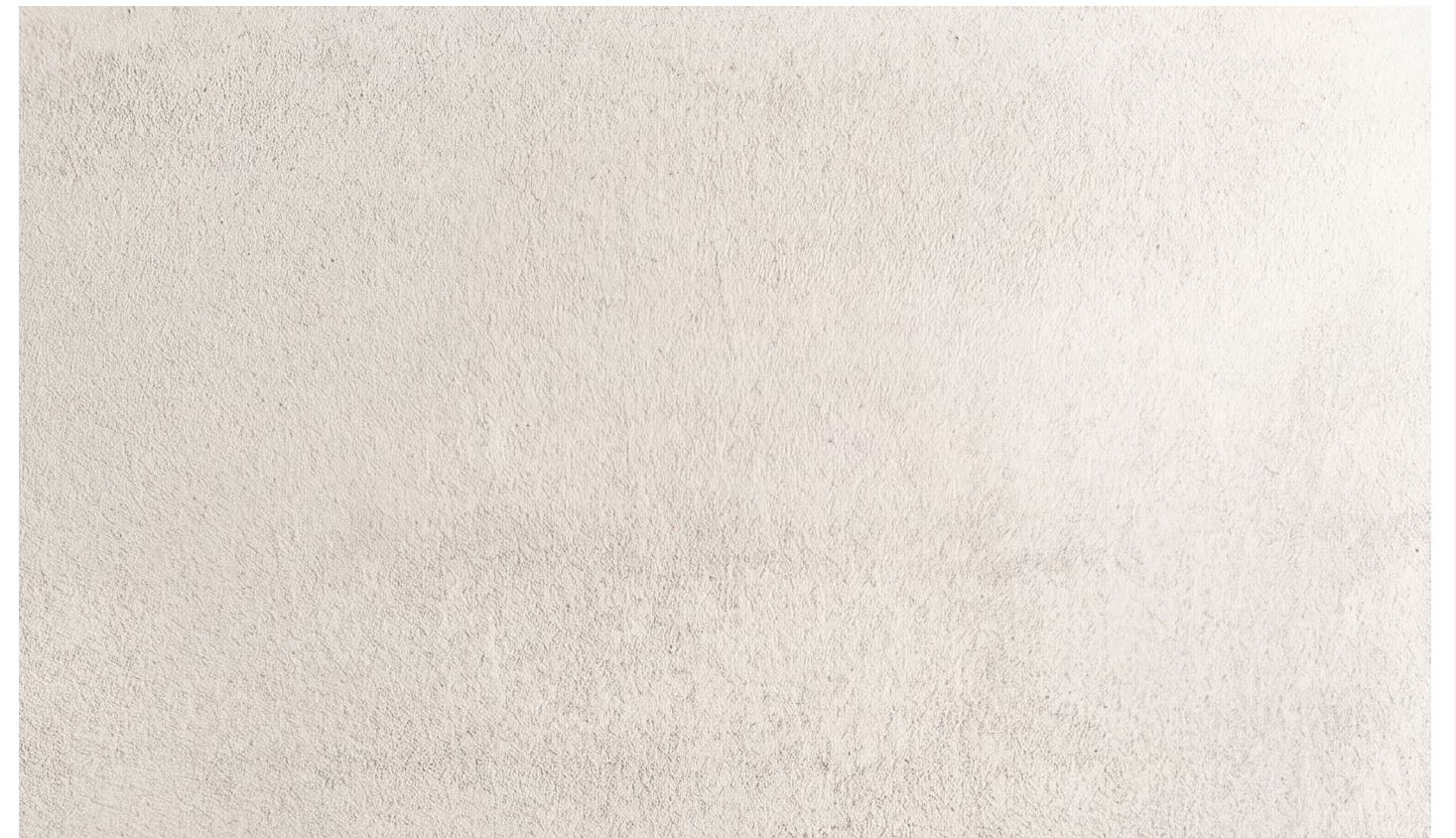
Lehmoberputz (weiß) auf Lehmputz
